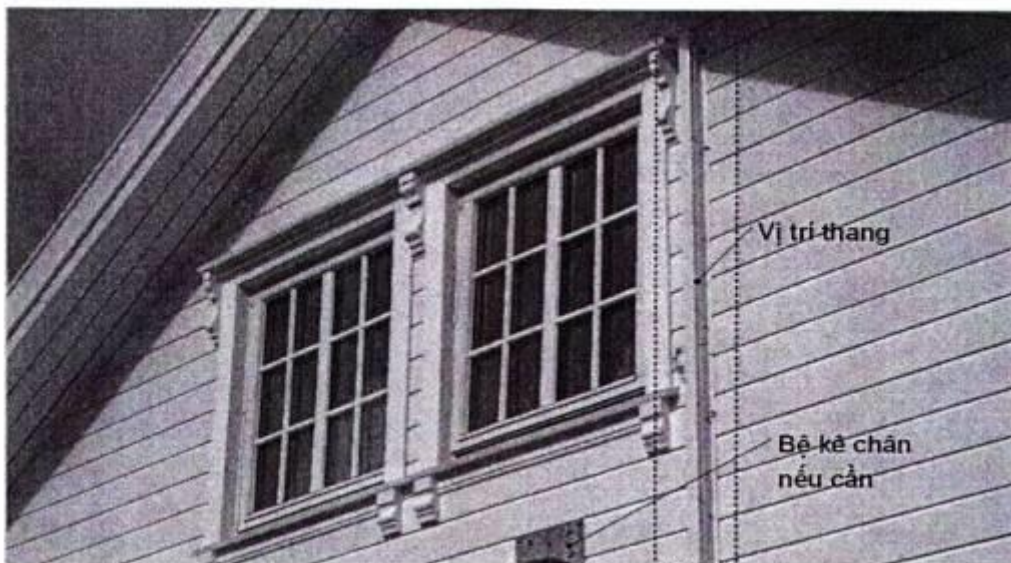
a) Thang ở trạng thái xếp dọc, ép sát bề mặt tường (vị trí lối ra khẩn cấp trên cùng)
